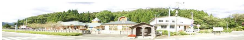
《保育園や公共施設をがけ崩れから守る法枠工》 《由利本荘市・上川原地区》
